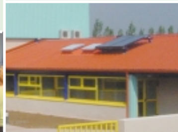
Chauffe eau solaire, salle des sports
